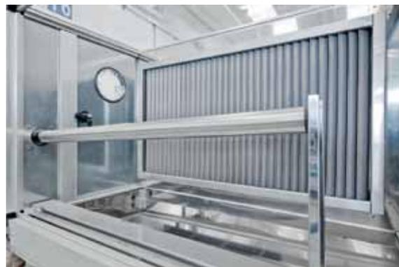
Illustration 5 : Tuyau à vapeur de l'humidificateur isothermique et de l'éliminateur de gouttes d'eau
